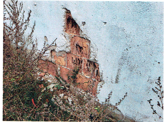
Fot. 26 Degradacja struktury ściany zewnętrznej od strony zachodniej
