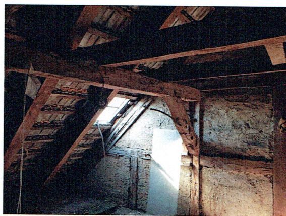
Fot. 4 Konstrukcja dachu. Widok na ścianę działową (strona wschodnia –ulica Koszalińska).
