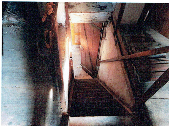
Fot. 5 Bieg schodowy o konstrukcji drewnianej, wejście na strych.
