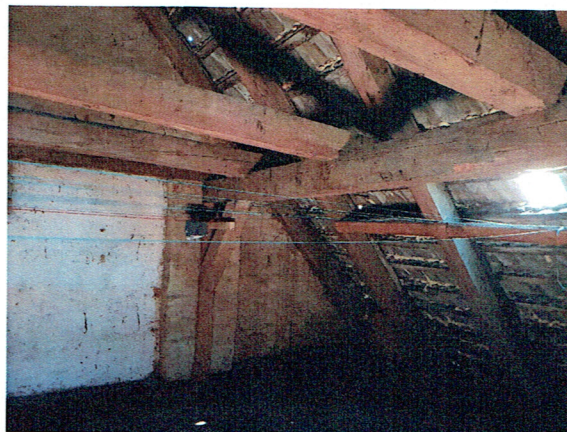
Fot. 2 Widok konstrukcji więźby dachowej od strony pomieszczenia strychowego, ściana szczytowa (strona zachodnia).
