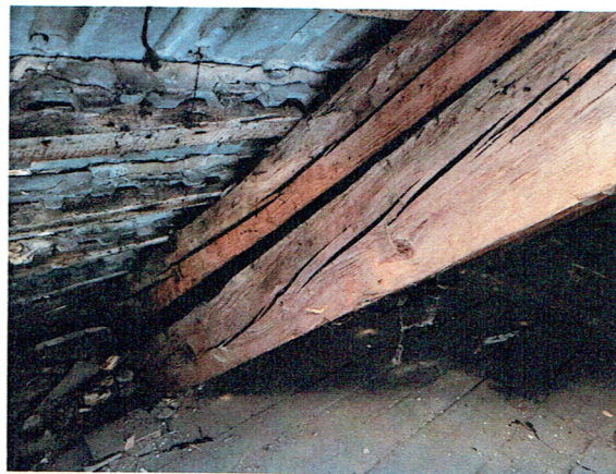
Fot. 14 Odspojona nadbitka krokwi (strona wschodnia).
