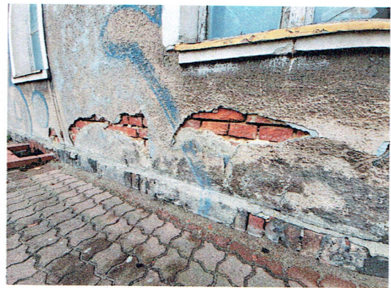
Fot. 28 Zniszczenia tynku elewacyjnego po stronie wschodniej spowodowane brakiem izolacji poziomej.
