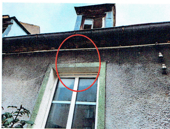
Fot. 22 Pęknięcie nadproża okiennego widoczne na ścianie zewnętrznej (strona zachodnia).
