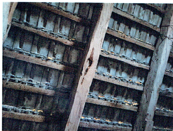
Fot. 20 Uszkodzenia elementu krokwiowego.
