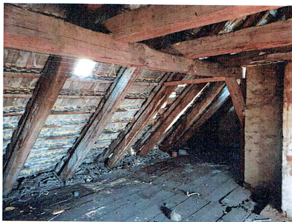
Fot. 1 Widok konstrukcji więźby dachowej od strony pomieszczenia strychowego (strona zachodnia).
