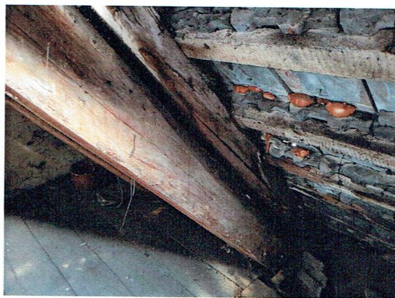
Fot. 16 Nadbitka odspojona od elementu krokwi.
