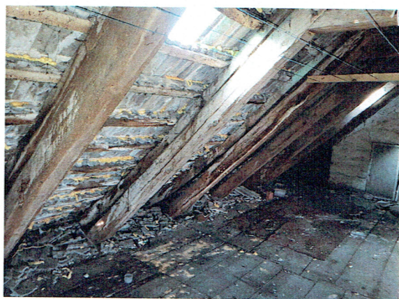
Fot. 21 Widok stanu technicznego krokwi dachowych na połaci wschodniej. Zły stan pokrycia dachówkowego.
